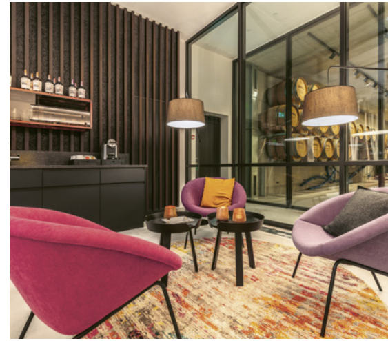
Zwei Brandschutzverglasungen (EI60 / EI90) bilden einen geschützten Korridor im Innern. Deux vitrages coupe-feu forment un corridor protégé à l'intérieur.
