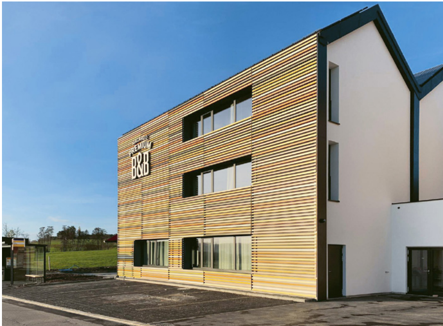
Die Ostfassade ist ebenfalls mit farbigen Lamellenprofilen bestückt. Côté est, la façade est également ornée de lames profilées colorées.
