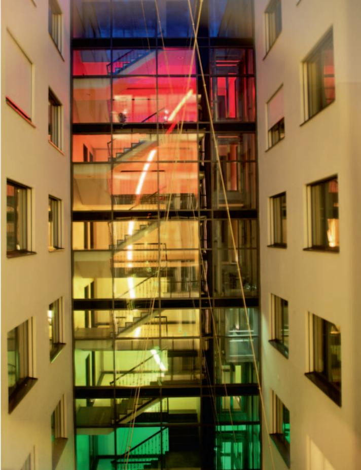
Die sechs Geschosse hohe Glasfassade ist als wärmegeämmte Brandschutzverglasung EI30 mit dem System Forster thermfix vario hergestellt worden. La façade en verre de six étages à base de vitrages coupe-feu calorifuges EI30 dotés du système Forster thermfix vario.
